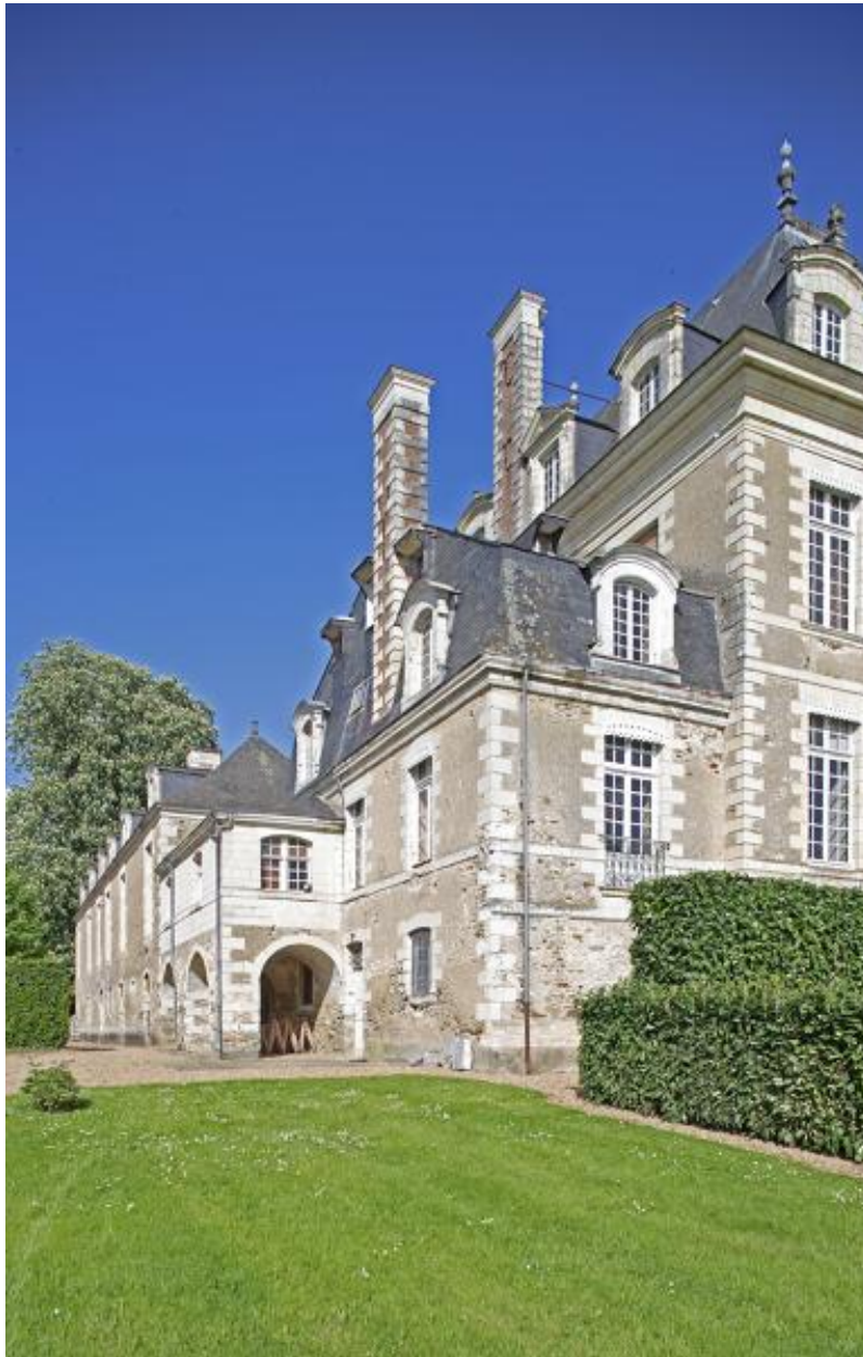
Le logis, partie sud : corps de bâtiment adossés au pavillon sud.
