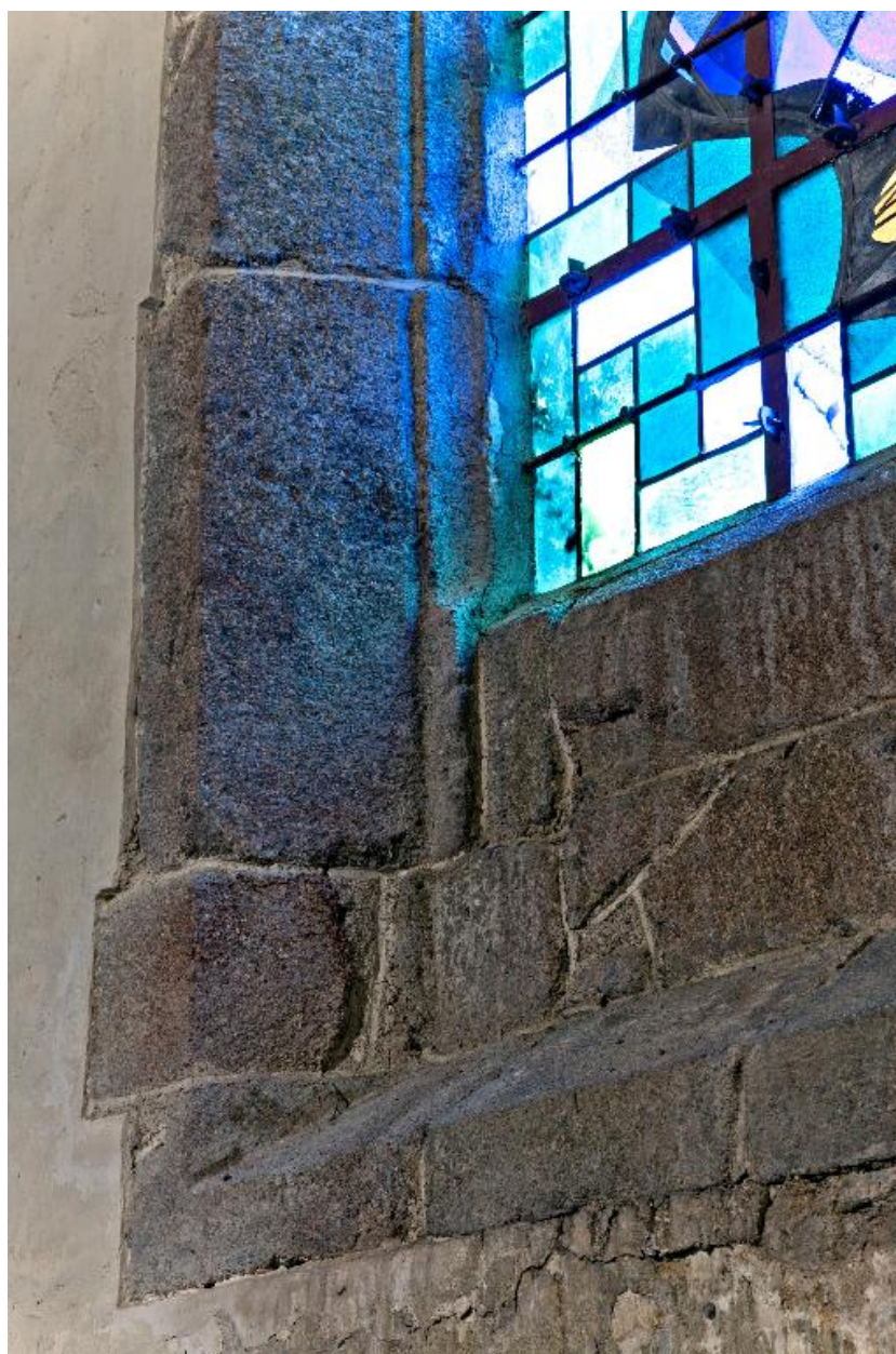
Détail de la mouluration de la fenêtre de la chapelle sud-est.
