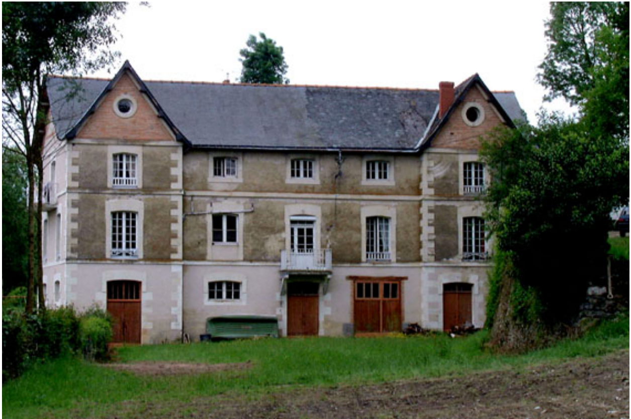
Maison du chauffournier sur le bord de la Sarthe, au pied du coteau : façade nord.
