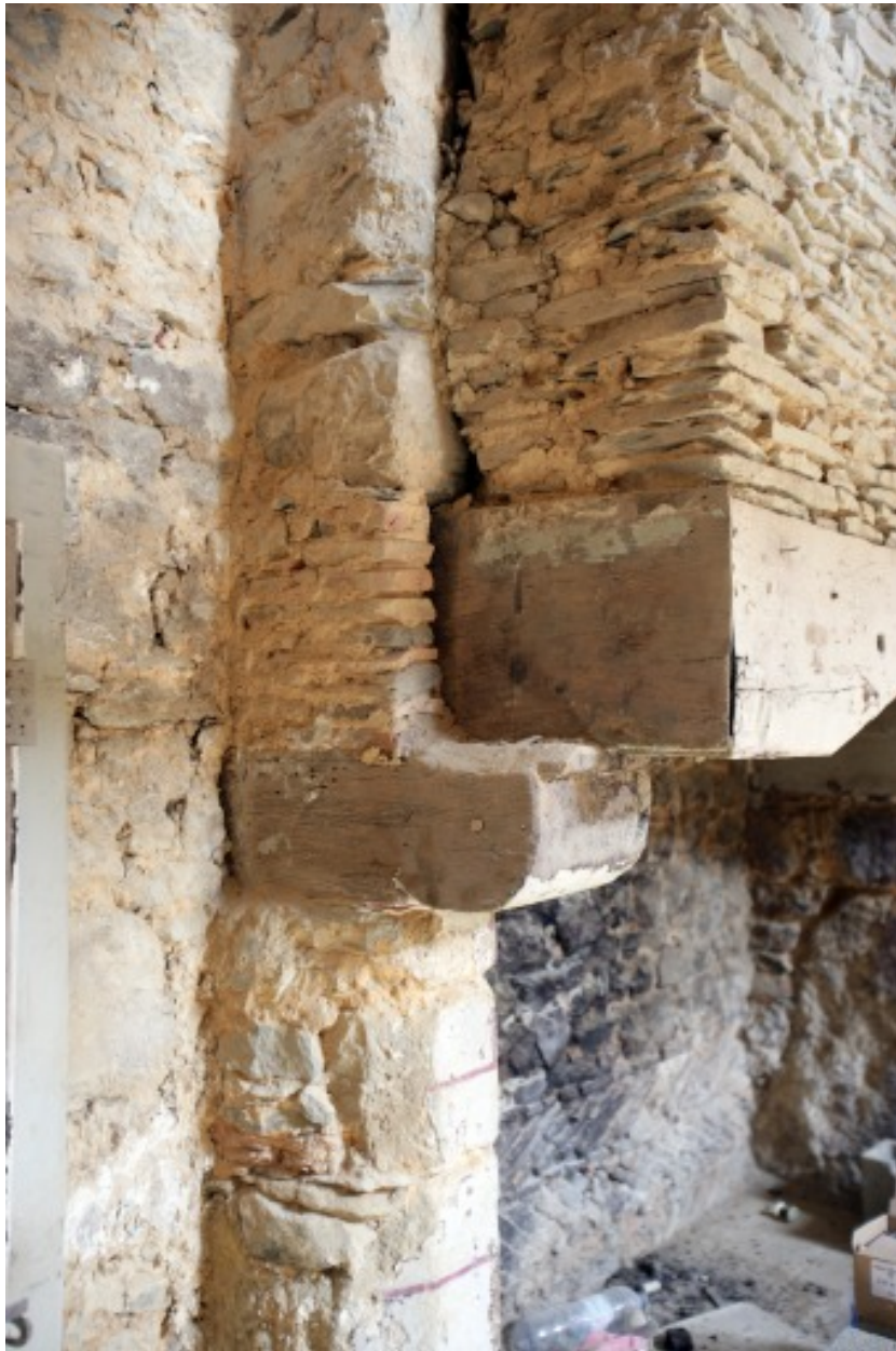
Intérieur du corps sud, rez-de-chaussée, pendant les travaux : vue de détail de la cheminée (partie ouest).
