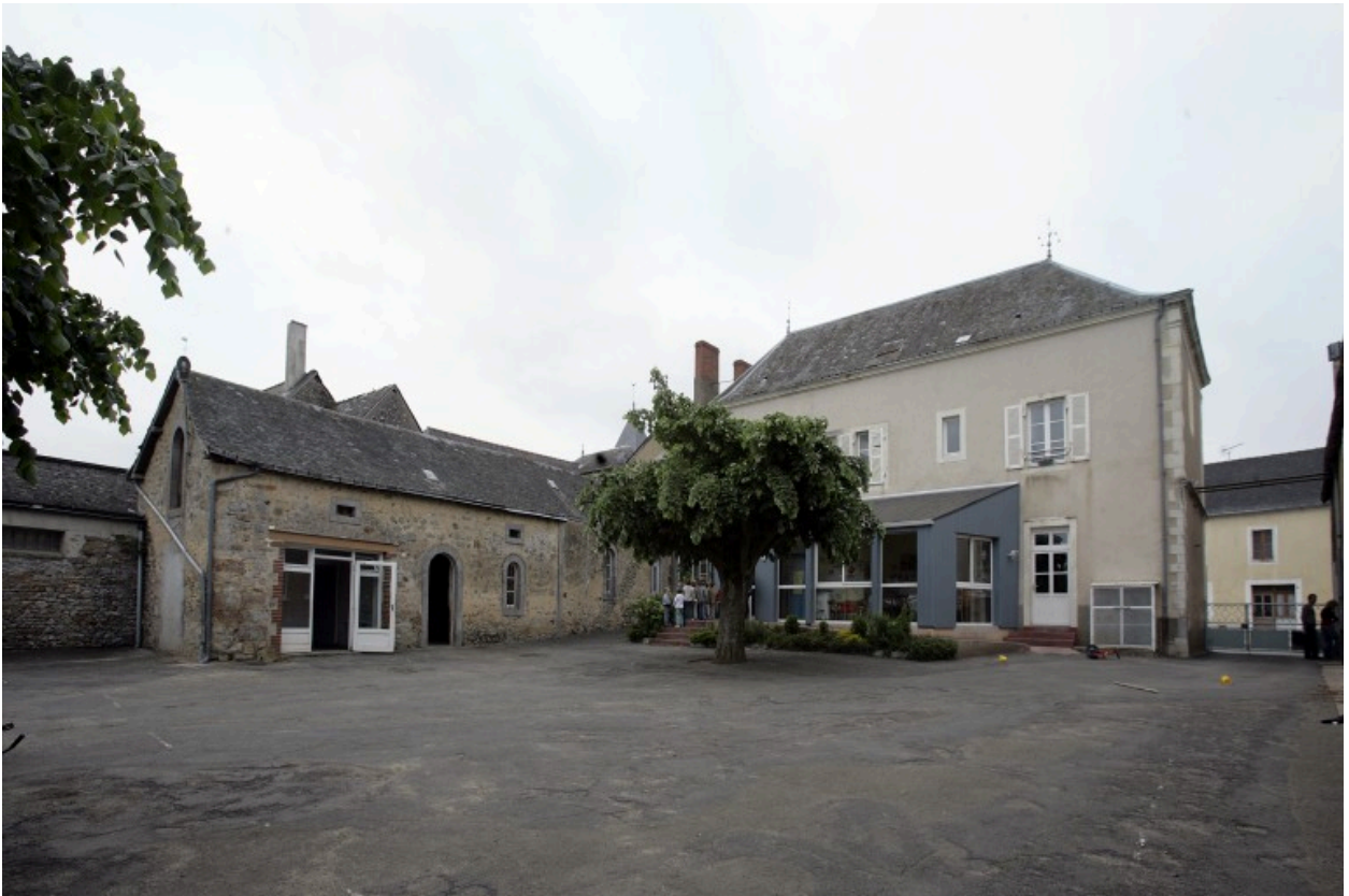
L'ancienne cuisine-cave et le bâtiment principal vus depuis la cour au nord.
