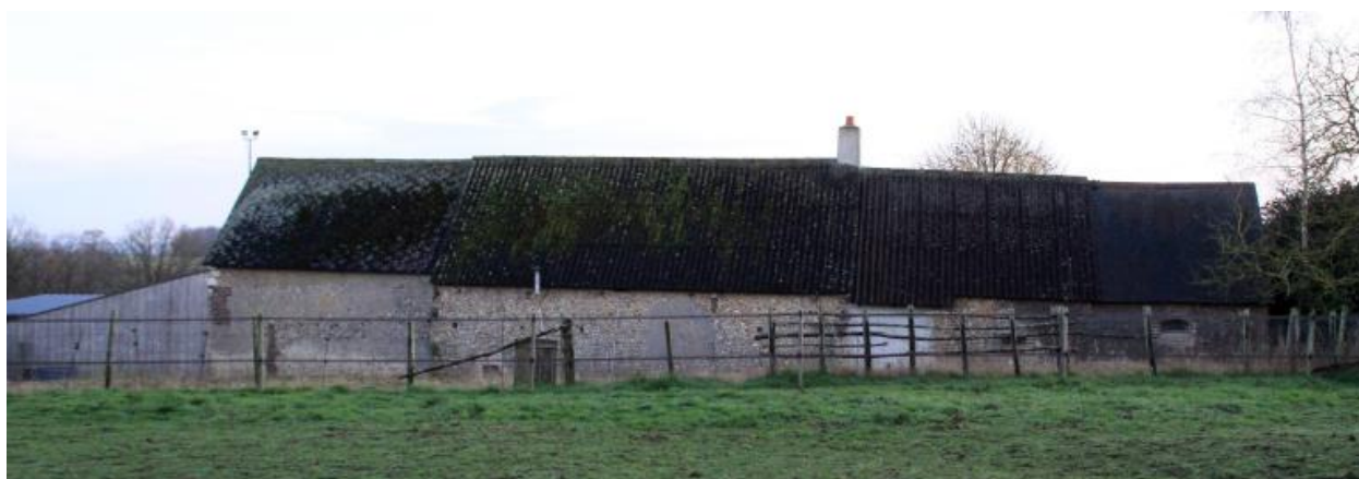
Ferme 5 : façade postérieure.
