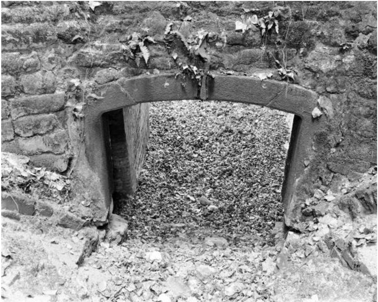
Four à chaux de la Jalousie, porte de déchargement est, vue depuis l'intérieur de la chambre de combustion, Maison-Blanche, Montjean-sur-Loire.
