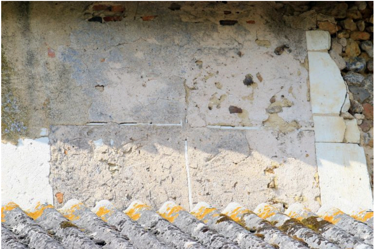
Habitation 2, logis, façade postérieure : vestiges d'une croisée en pierre.
