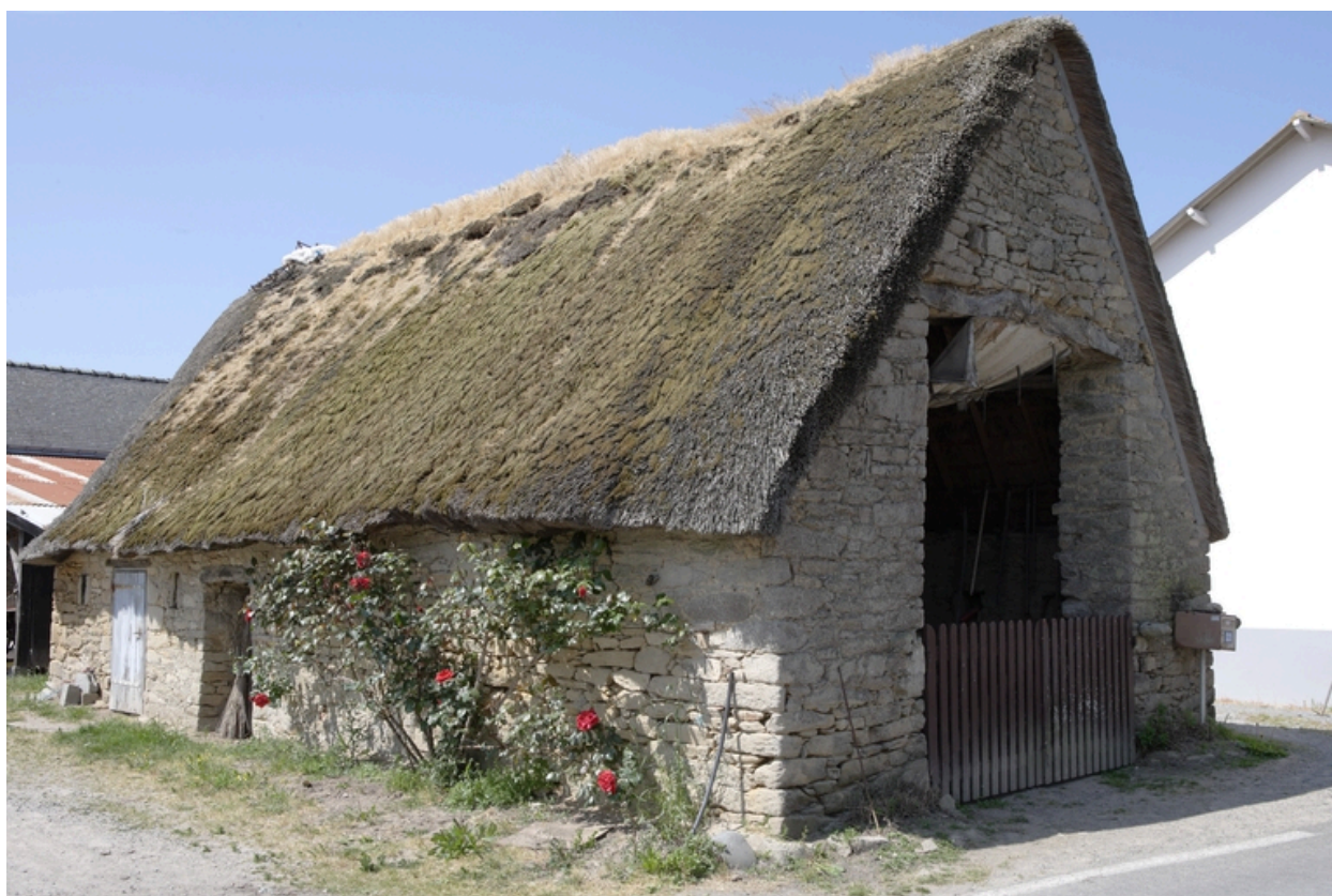
Vue de la remise depuis l'est.
