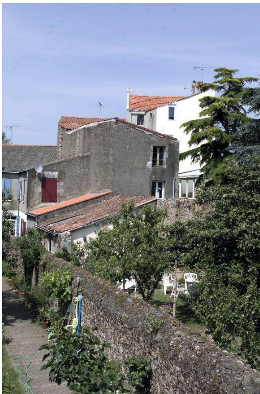
Vue des corps secondaires des maisons n° 23, n° 21, n° 19.
