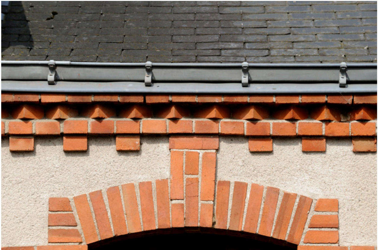
Maisons ouvrières de la Société Anonyme de Chaussures, rue Jeanne d'Arc : détail de la corniche et de l'encadrement d'une baie.
