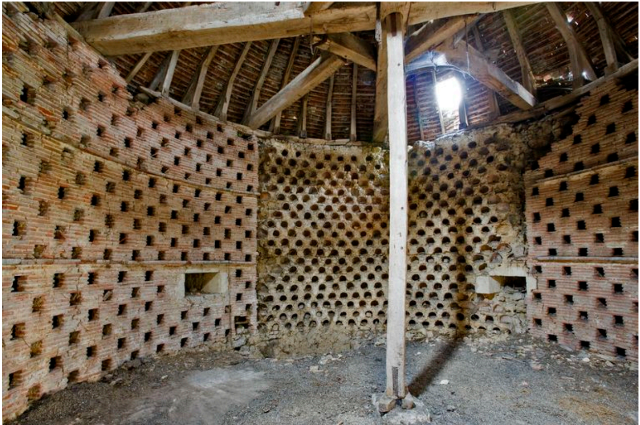
Vue intérieure de l'étage du colombier
