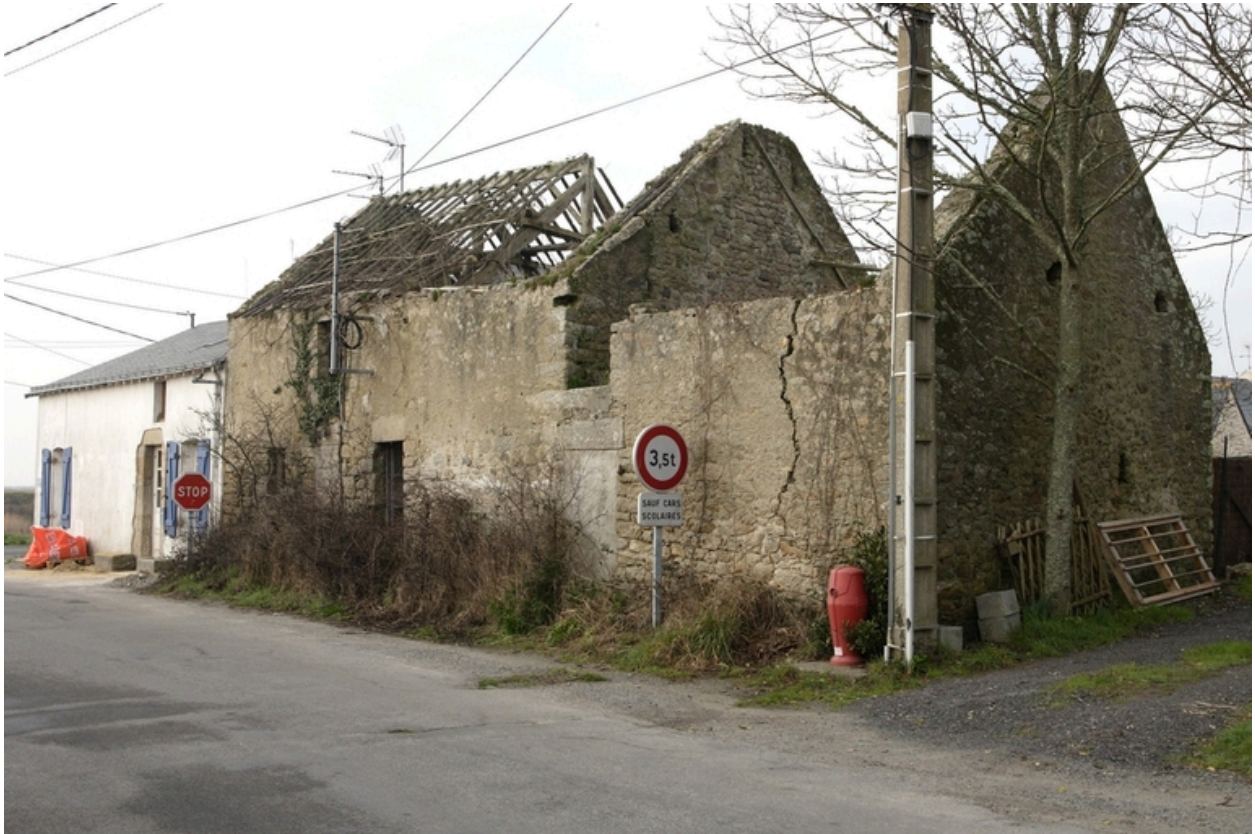
Vue d'ensemble du 26 rue de Kérignon.
