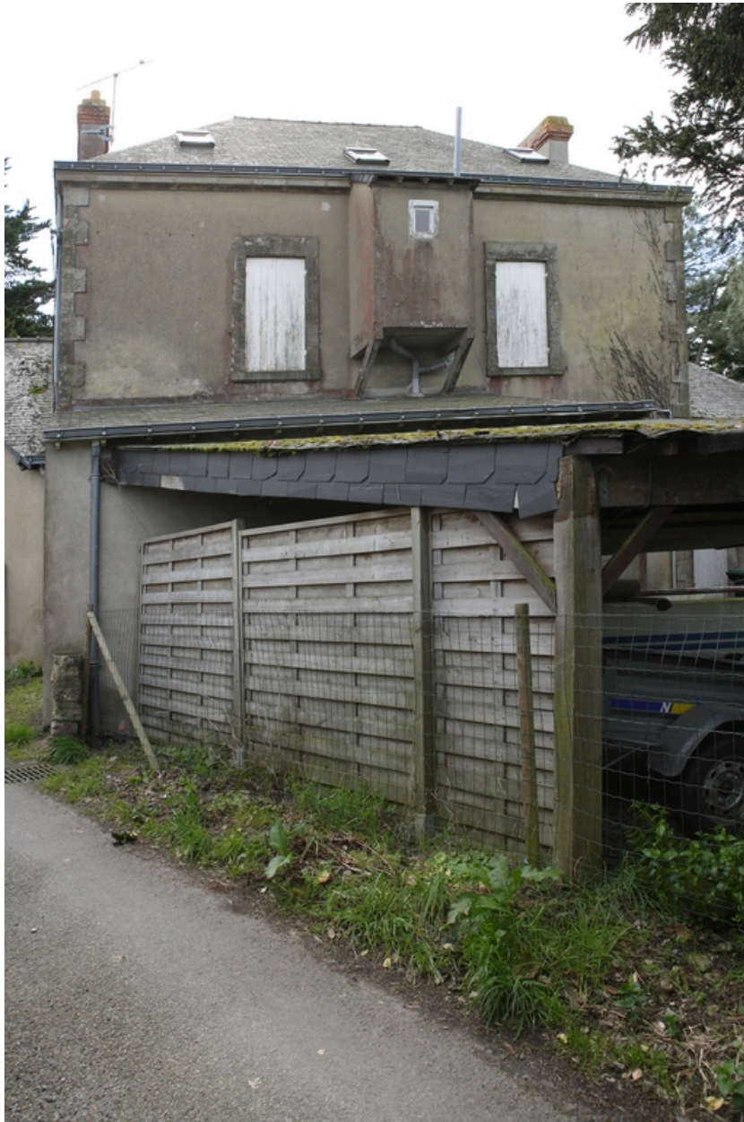
Vue de la façade nord.
