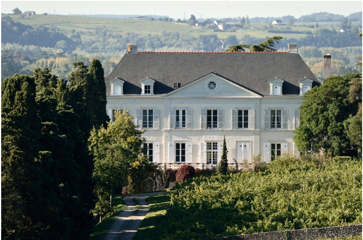
Vue depuis le nord.
