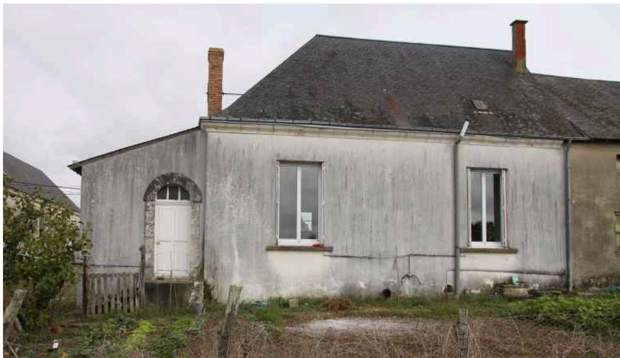
La maison d'habitation : façade postérieure.
