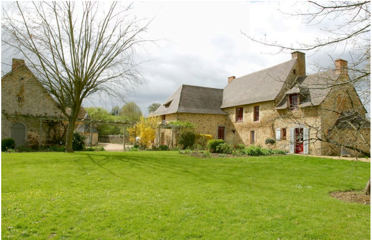
Le logis. Vue d'ensemble depuis l'est.
