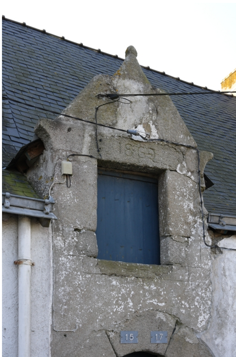
Détail de la lucarne datée 1862 du n° 17 rue du Rocher.
