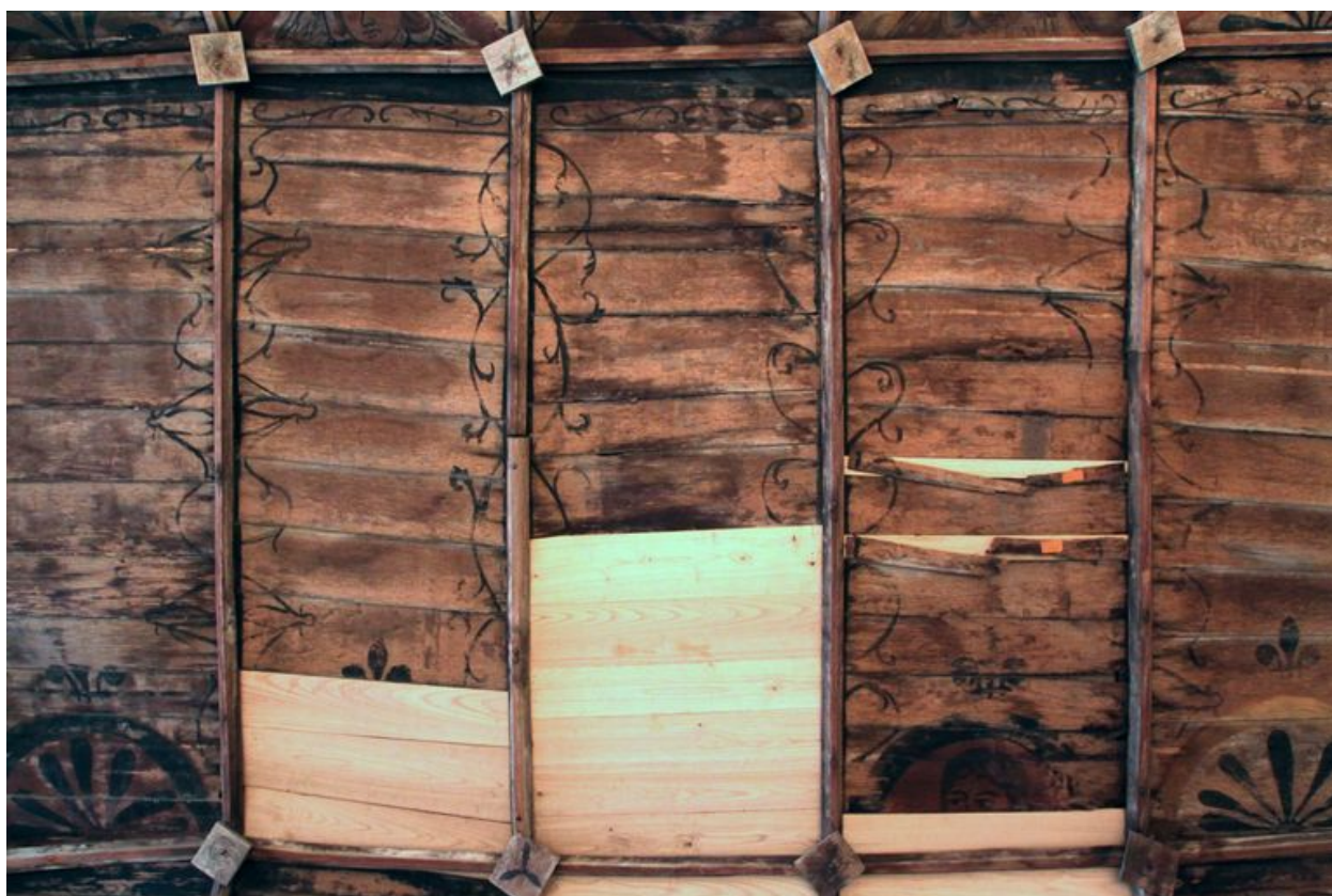
Nef, voûte lambrissée, côté sud, deuxième travée : registre médian après les travaux effectués en 2010.
