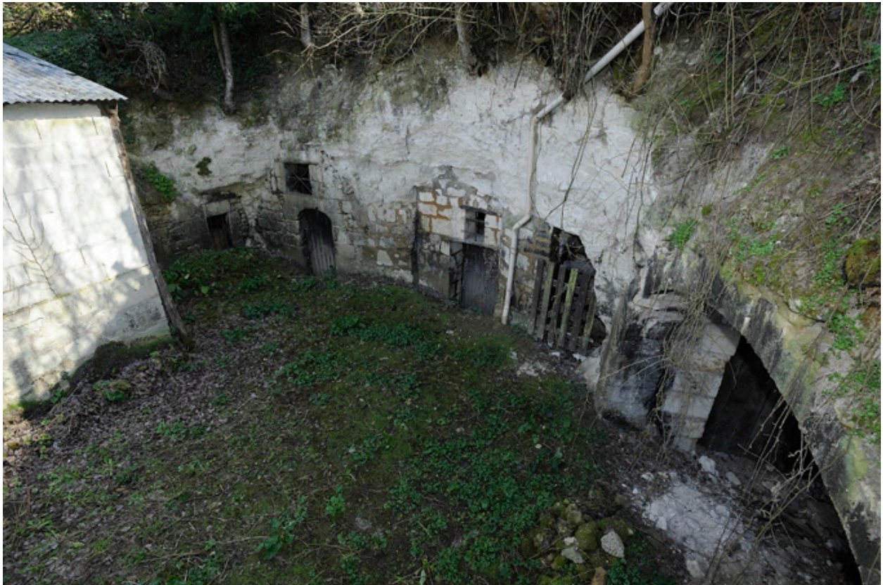
Vue générale de l'ensemble troglodytique à cour commune
