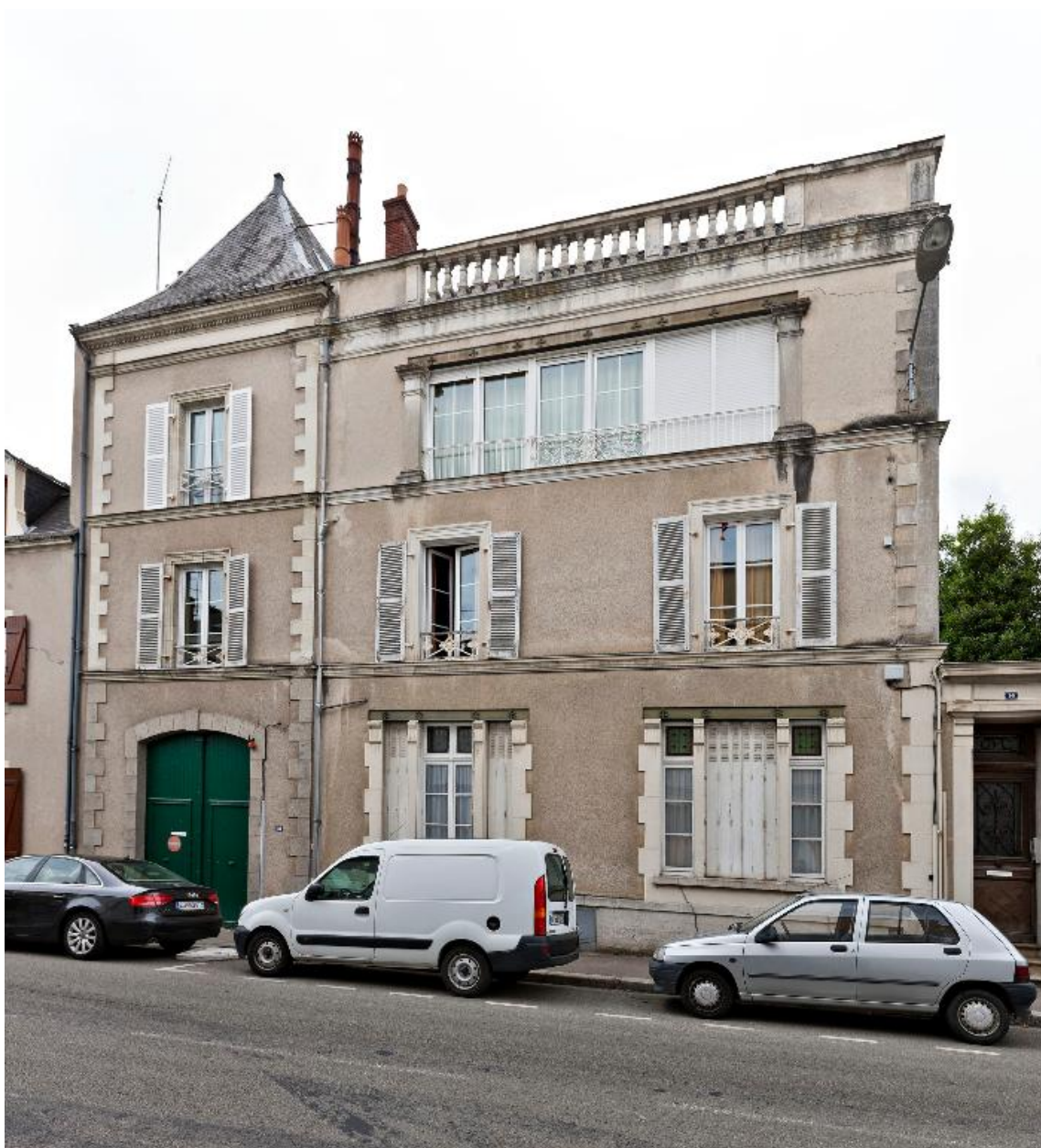
Elévation sur rue : vue d'ensemble.
