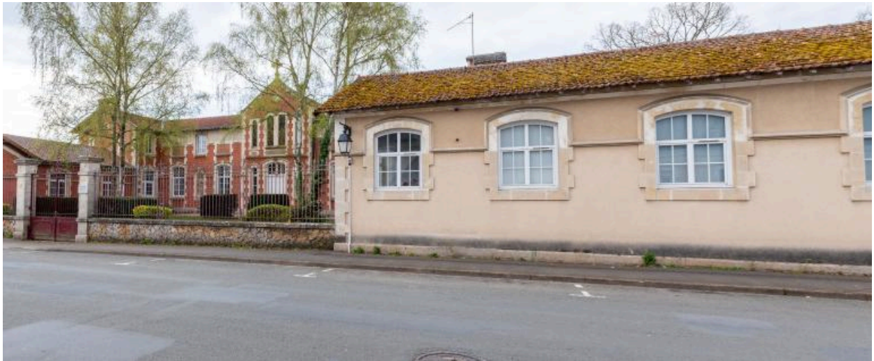
Les bâtiments depuis la rue.
