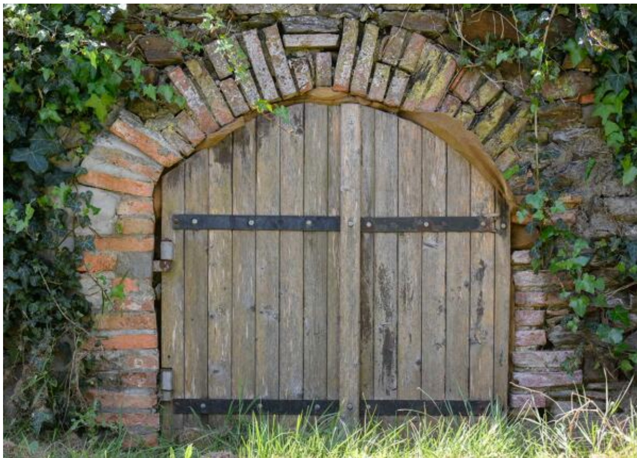
Façade est. Détail de la porte de la cave.
