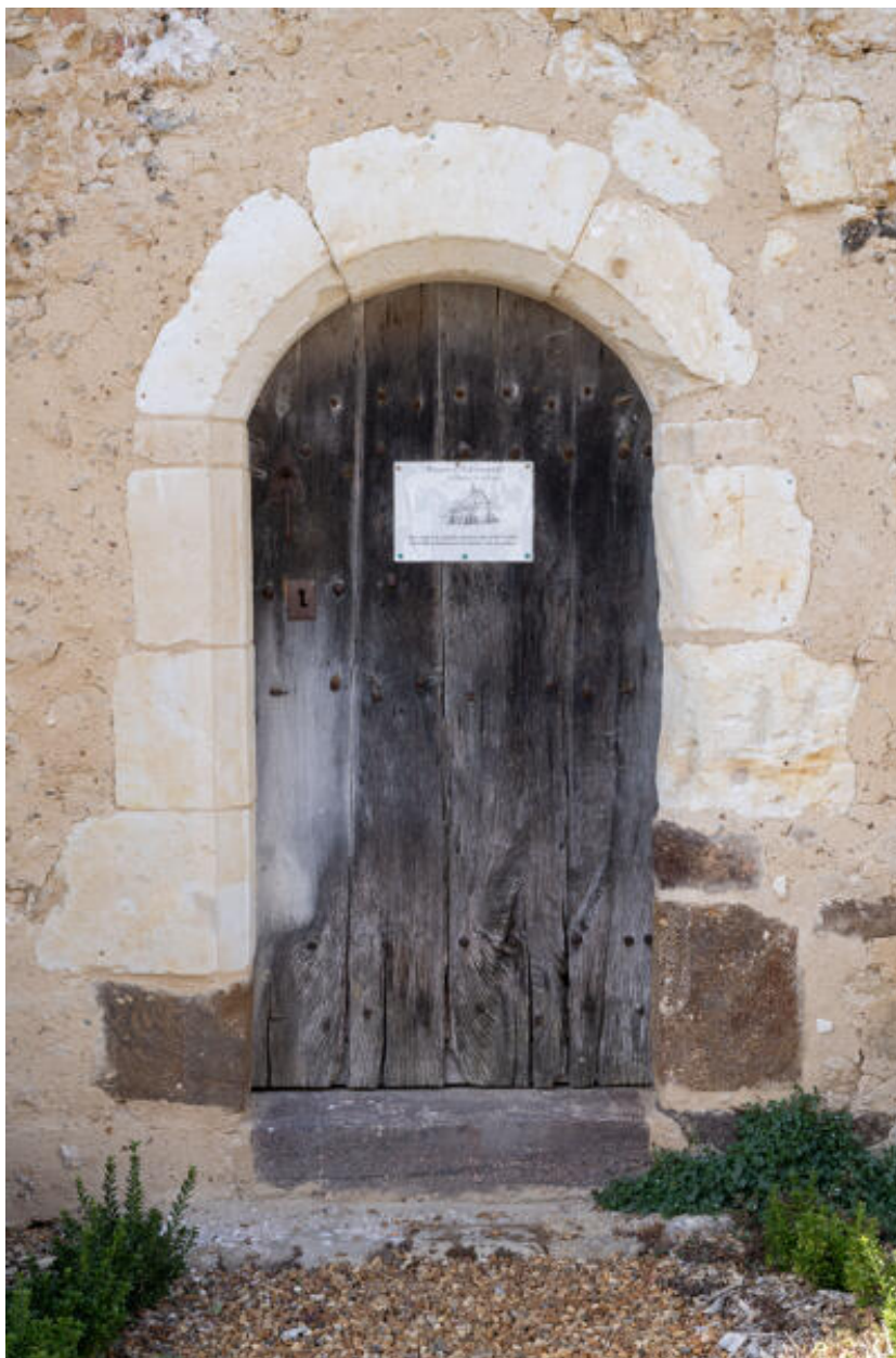
Porte latérale de la nef, côté sud-est.
