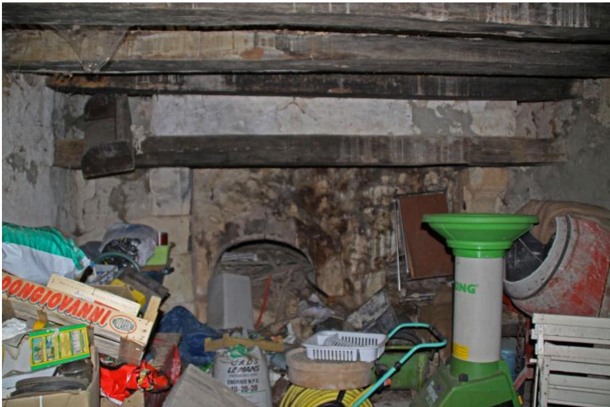
Buanderie : cheminée équipée d'un four à pain.
