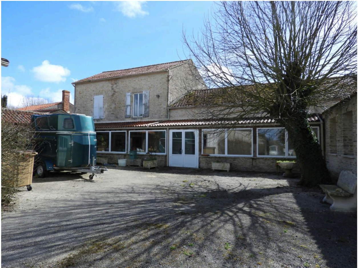
Vue depuis le nord.
