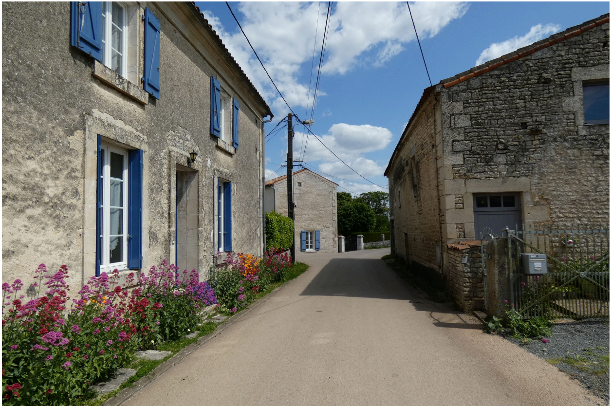
Habitations et dépendances agricoles dans le bourg, rue de la Crie.
