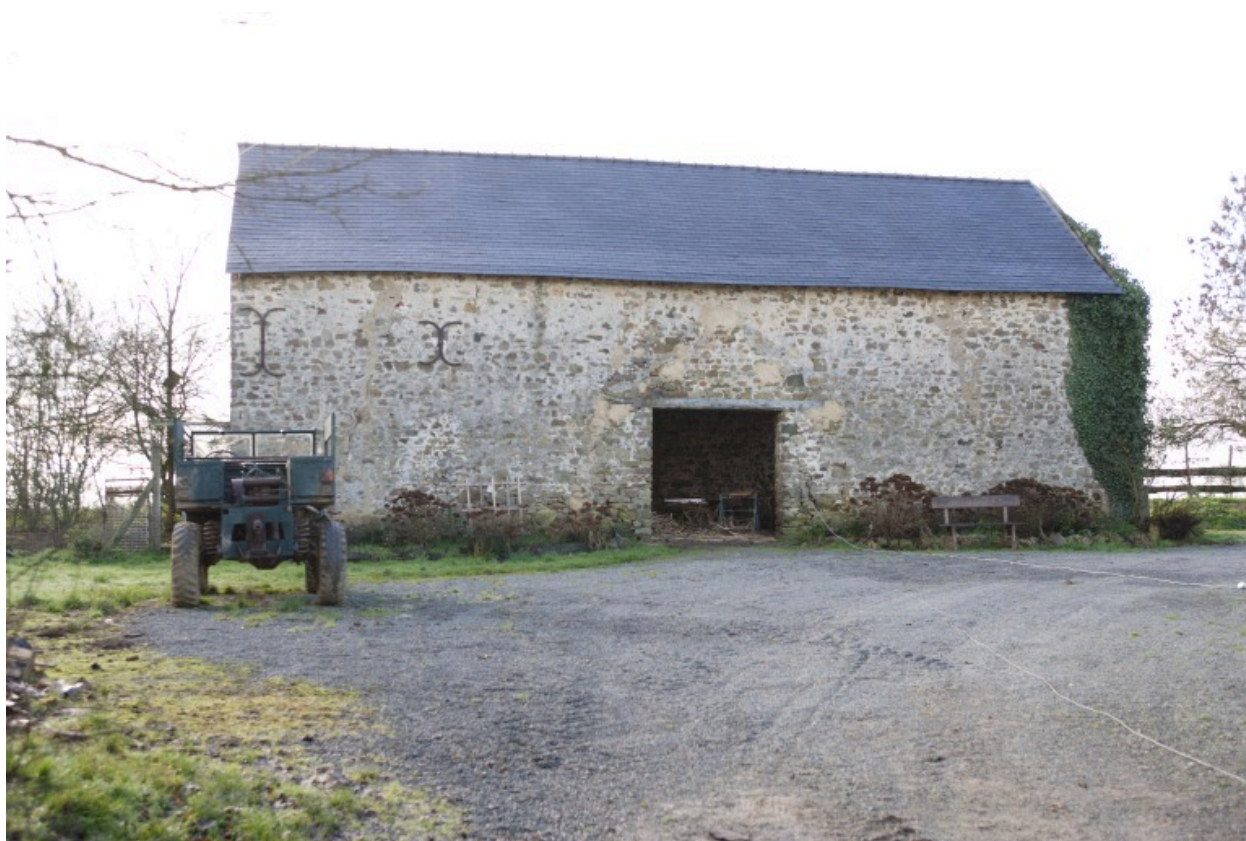
La remise vue depuis le nord.
