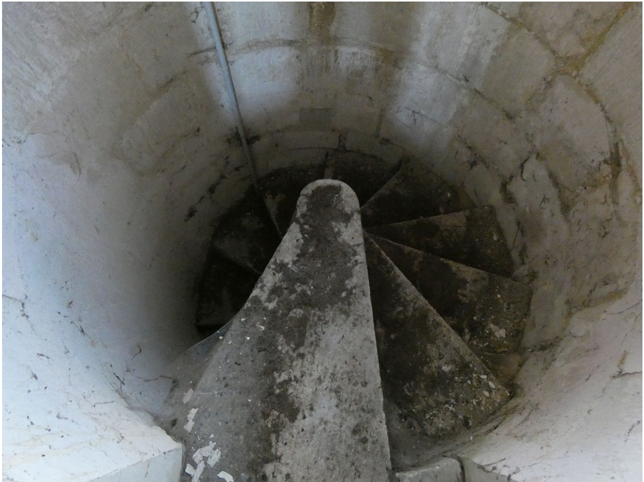
Le sommet de l'escalier en vis du clocher.
