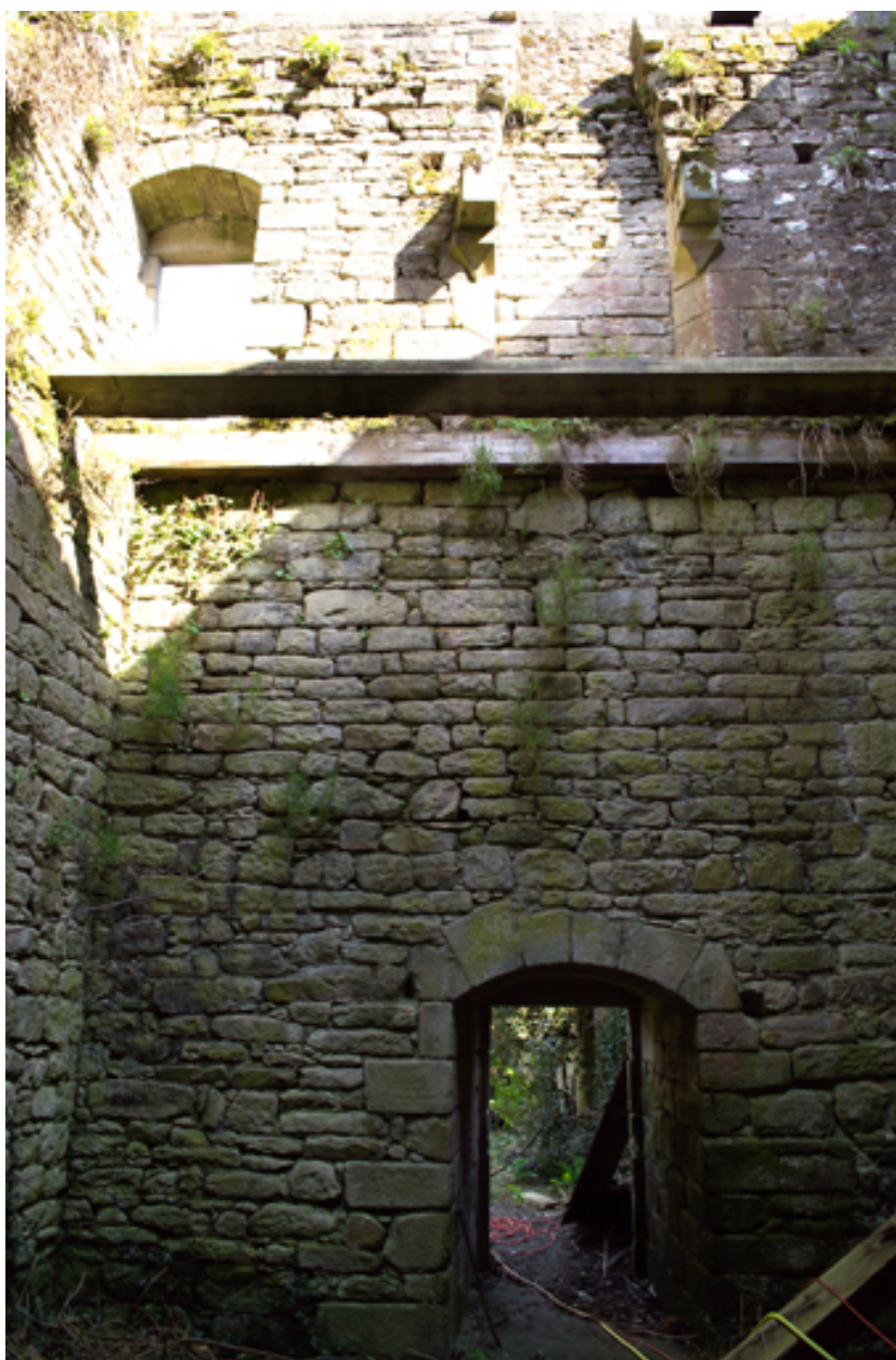
Parement interne du mur est.
