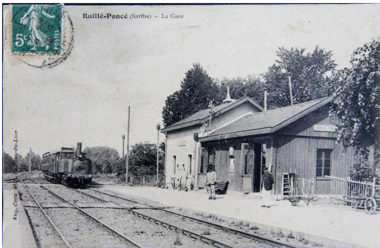
Ruillé-sur-Loir, les Basses Touches : gare (détruite) de Ruillé-sur-Loir/Poncé-sur-le-Loir, PN 115.
