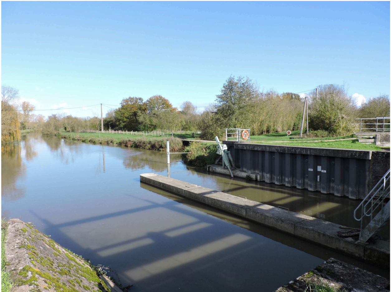
La Jeune Autise et la structure amont du barrage sur le second aqueduc, vus depuis le sud-ouest.
