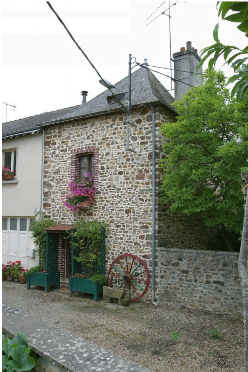
Façade sur rue du corps de bâtiment ouest..
