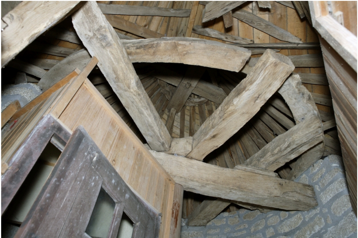
Tour d'escalier. Enrayure.
