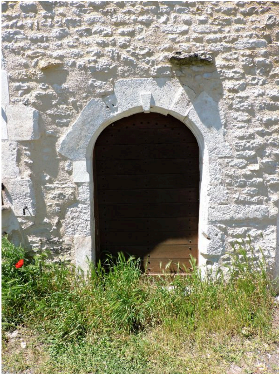
La porte en arc en plein cintre (17e-18e siècle).
