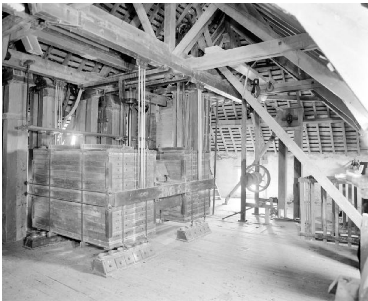
Comble du moulin. Le plansichter.
