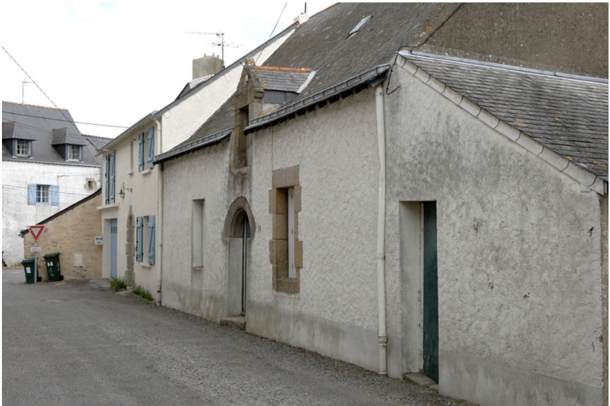
Vue du n° 3 rue Courte-Baille.
