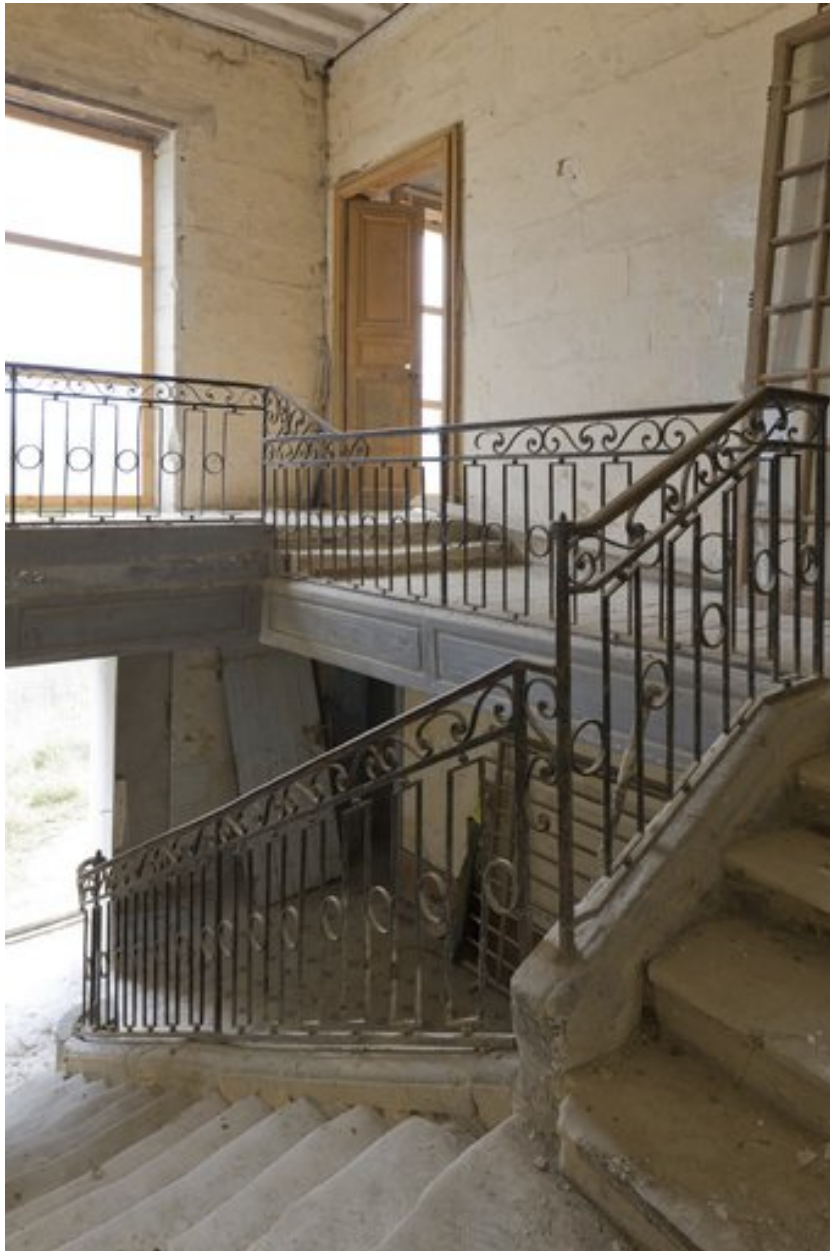
Escalier tournant établi vers 1800, vue d'ensemble.
