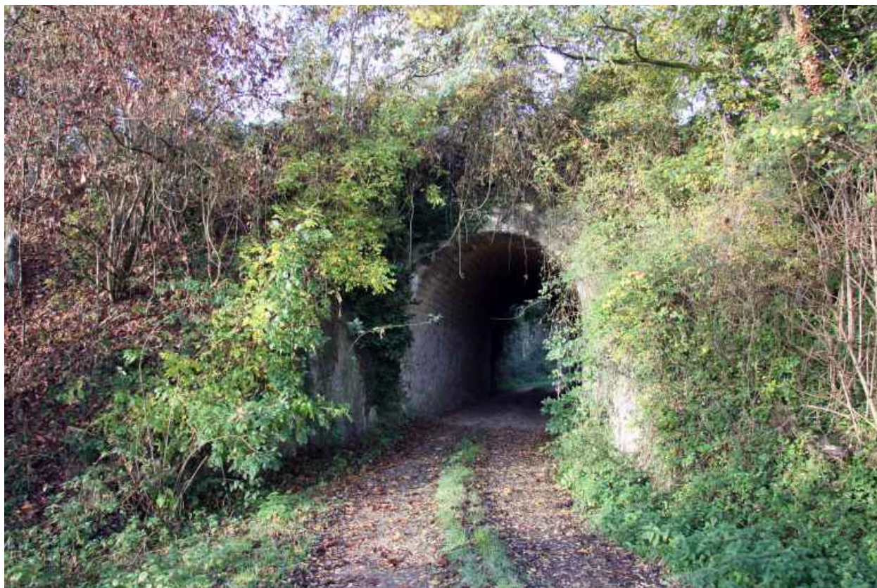
Tunnel sous la voie avant le viaduc, de l'est vers l'ouest.
