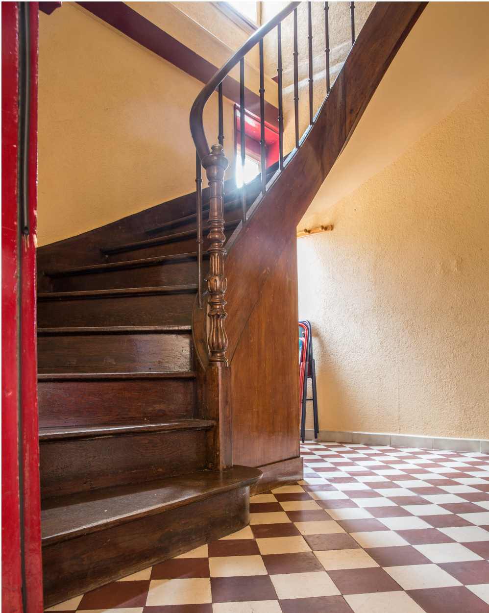
Le logement de l'école, l'escalier.
