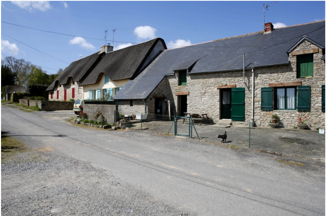
Vue de la rangée depuis l'est.
