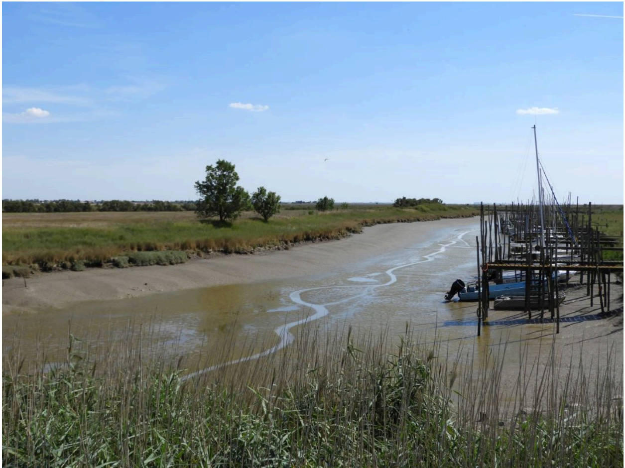
Le chenal en aval de la porte, vu en direction du sud.
