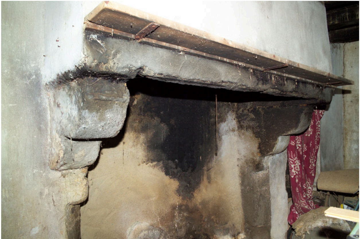
Cheminée de l'avant-dernier logement à l'est.
