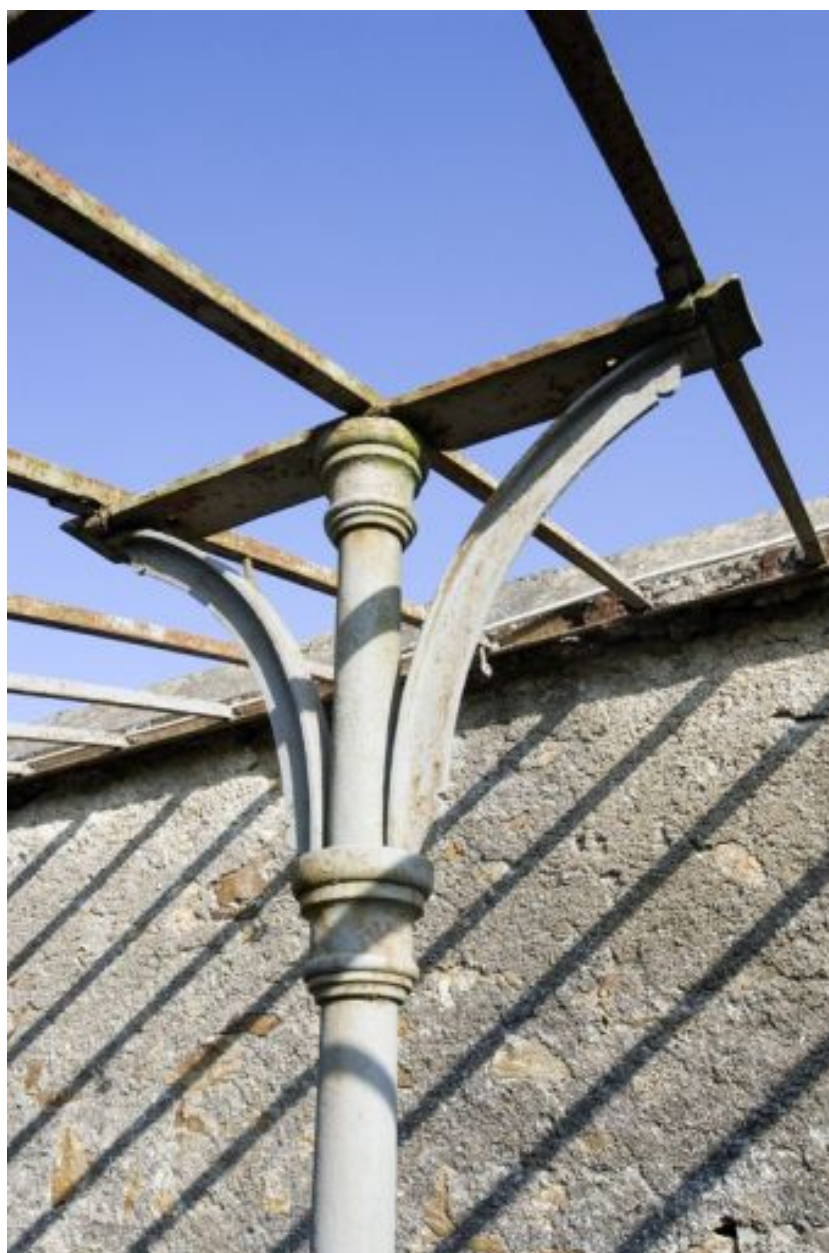
Jardin. La serre adossée : détail de ferronnerie.
