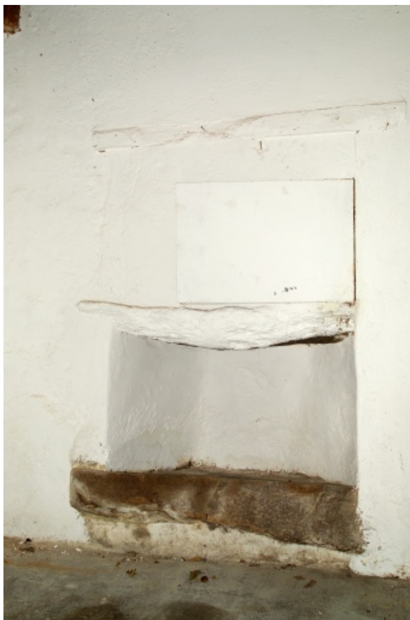
Evier du rez-de-chaussée sur le mur ouest.
