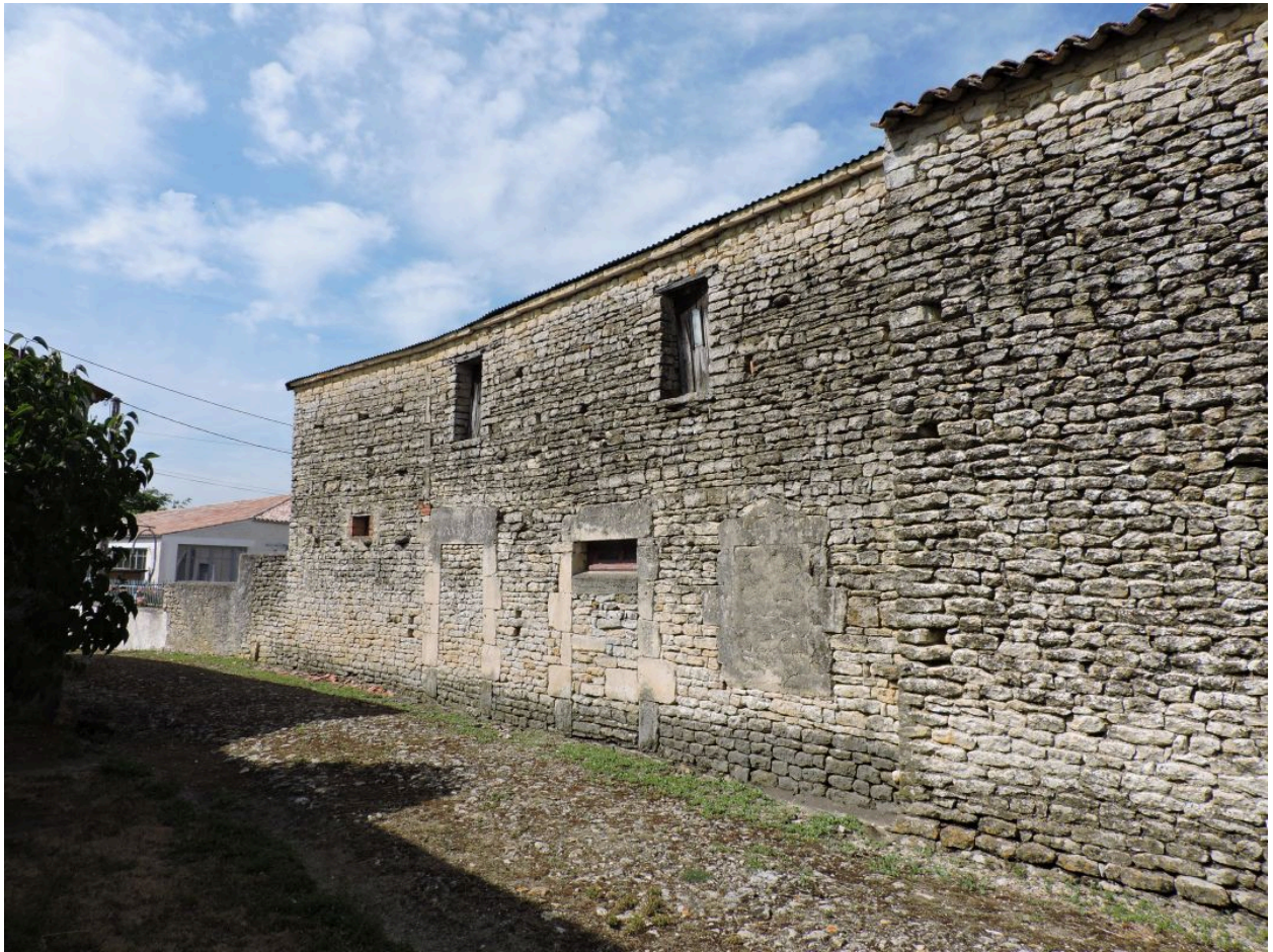
La façade sud de la grange-étable, ancien logement.
