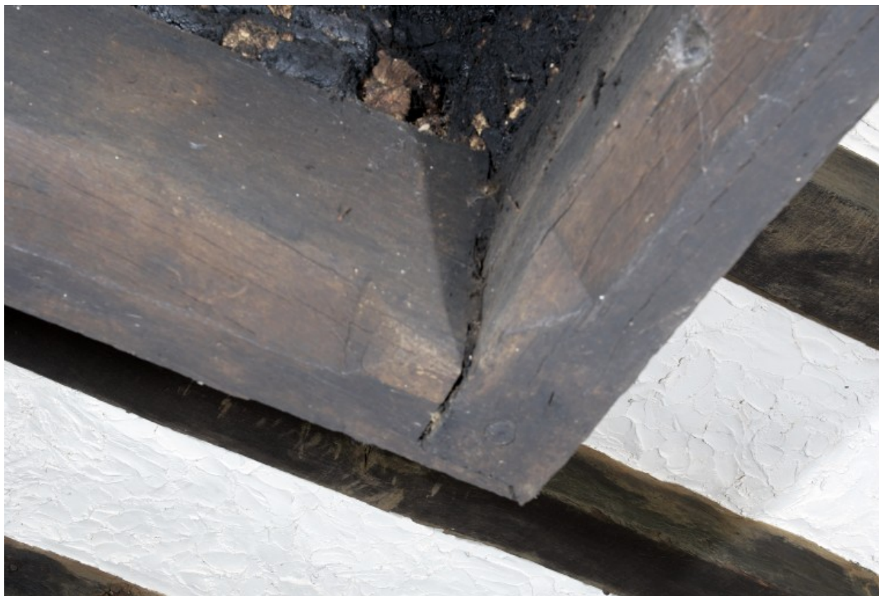
Corps sud du logis, pièce ouest, détail de la cheminée : assemblage du manteau.
