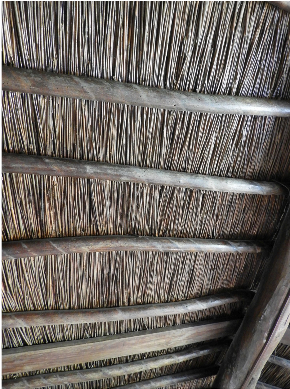
Couverture en roseau à l'intérieur du logis.
