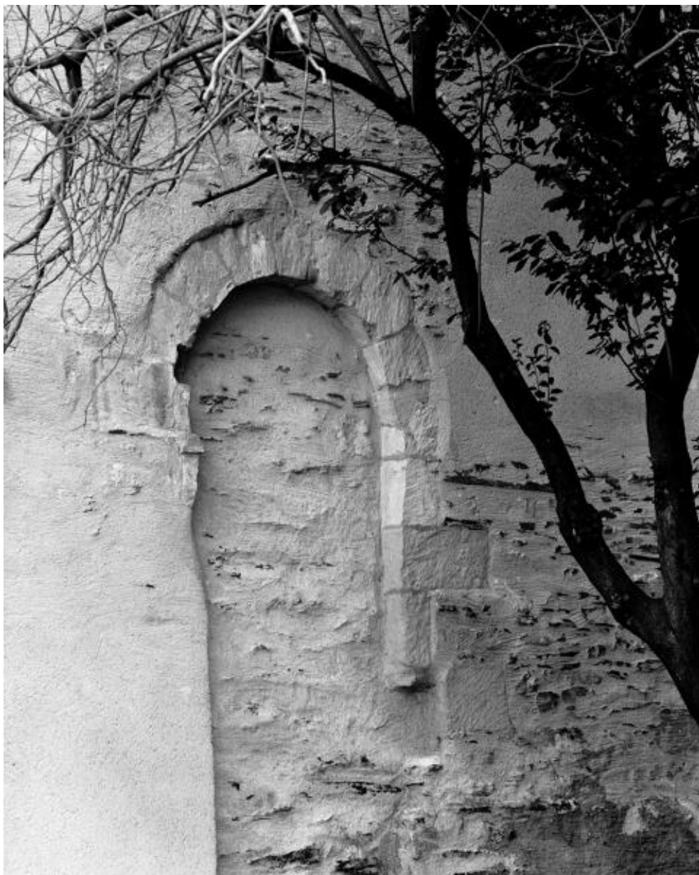
Premier logis abbatial, pignon sud : vestiges d'une baie en plein cintre du XIIe siècle.
