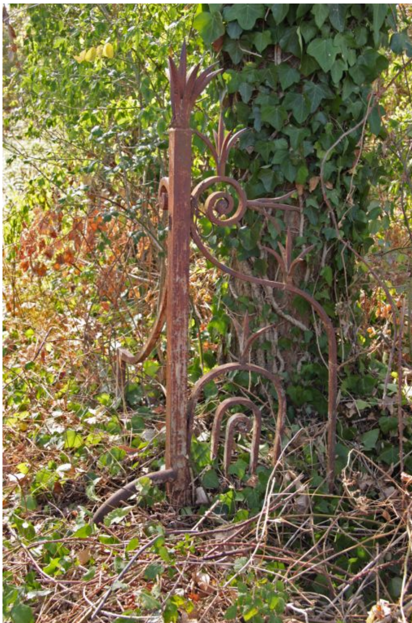
Poteau droit de la barrière.
